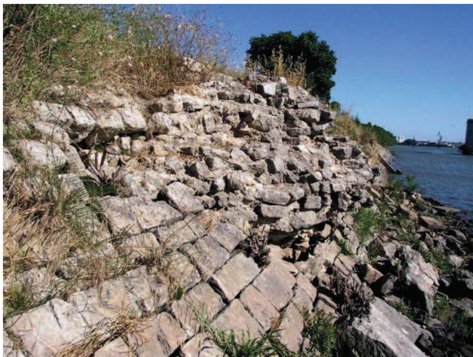
Figure 9. Gros plan du massif de blocage sans parement engagé dans le quai, qui correspond aux ruines du pont romain. Les blocs de parement ont certainement été récupérés pour d'autres utilisations. Il ne reste en place que le remplissage constitué de pierres et de ciment de chaux.
