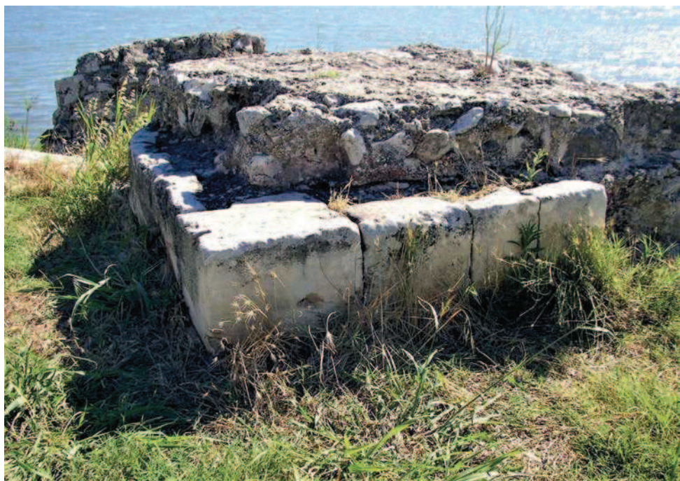
Figure 11. Aspect du parement en pierres encore en place sur les ruines du pont médiéval, côté trinquettaillais. (Collection Jean Piton.)
