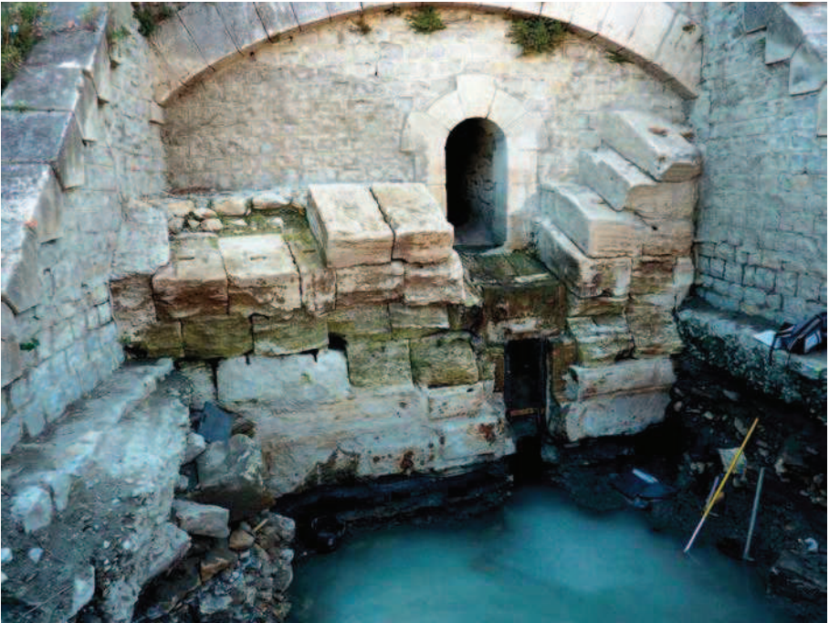
Figure 12. Ruines du pont depuis toujours considéré comme romain, côté ville, dégagées sur une hauteur de 3,60 m. On aperçoit aisément les pièces de bois utilisées en fondation et que les analyses ont permis de dater des temps médiévaux.
