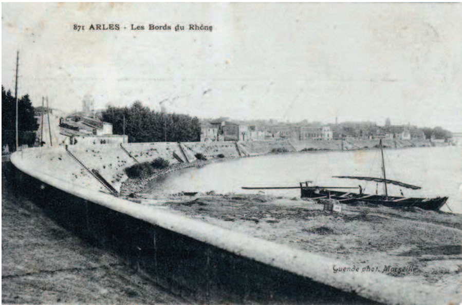
Figure 3 - Carte postale timbrée de 1909 montrant un dépôt de sable et de limons dans le virage du fleuve.
